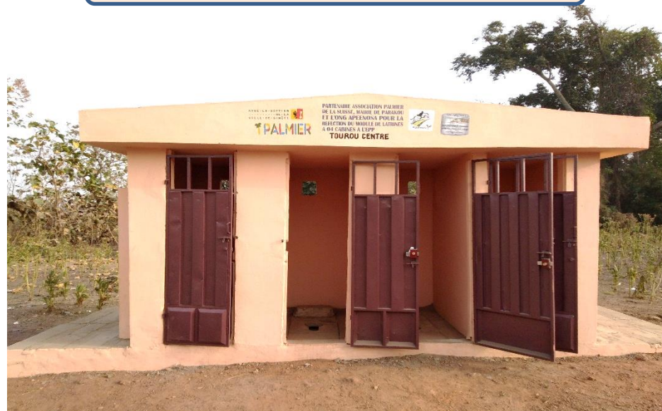
Les 4 latrines réfectionnées
