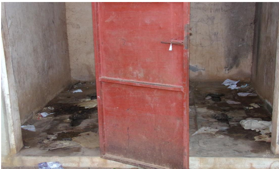
L'état de l'intérieur des latrines avant réfection
